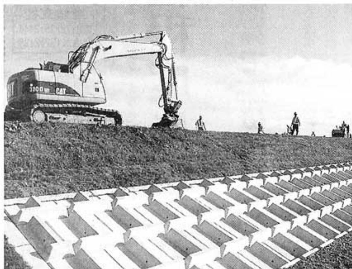
堤防は完成した。舗装や仮堤防の撤去などが進められている
